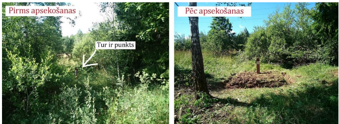
Valsts ģeodēziskā tīkla punkta (grunts repera) apsekošana un sakārtošana
